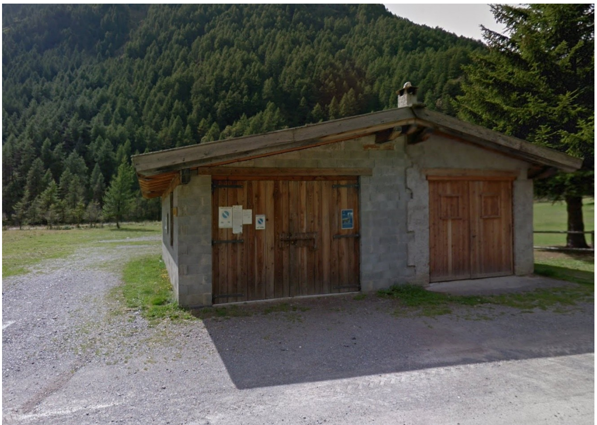
Fotografia n.1 _ vista esterna dell'edificio esistente
